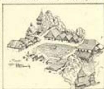
Потиліч, загальний вид.
