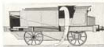
5. Тендер із прокладом до автоматичного заборони води підчас їзди.
